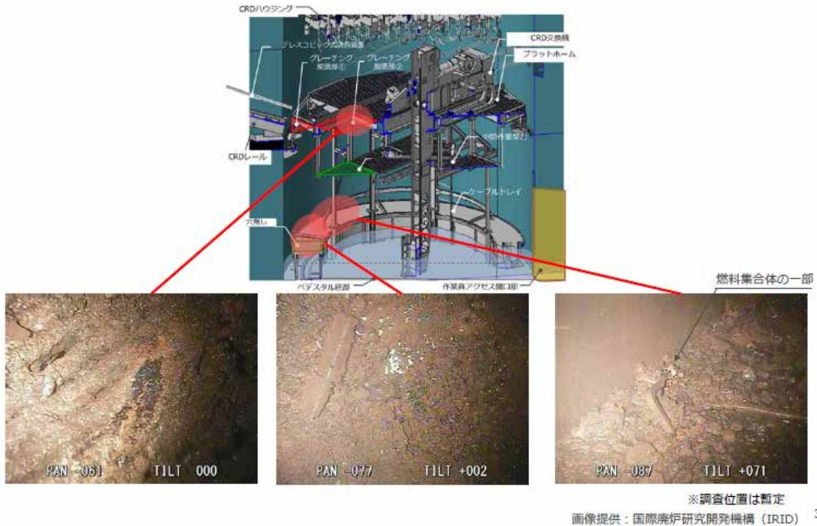
図 8.2-2 福島第一原子力発電所 2 号機 PCV 内部調査結果<sup>[8.2-2]</sup>
