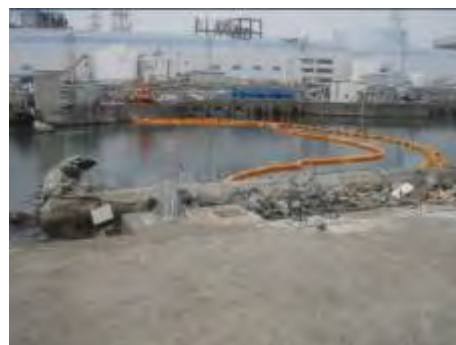
シルトフェンス設置
