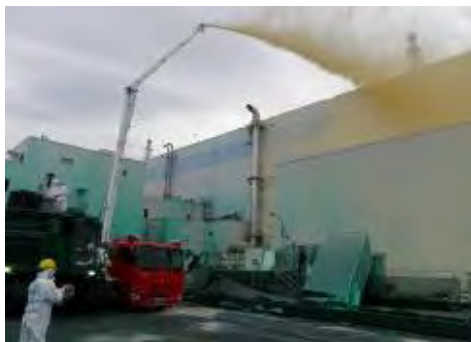
敷地、建屋本体への飛散防止剤散布
