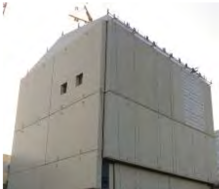
1号機原子炉建屋カバー設置
