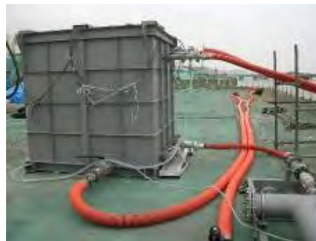
海水循環型浄化装置設置
