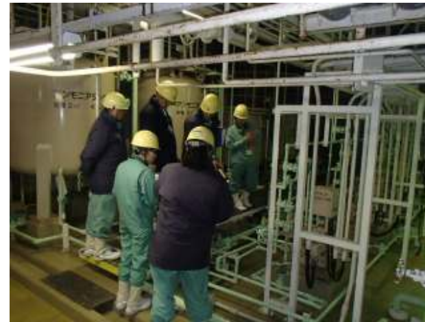
薬品注入装置のラインアップ確認
