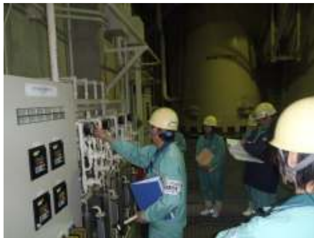
復水検塩装置での試料採取、系統確認
