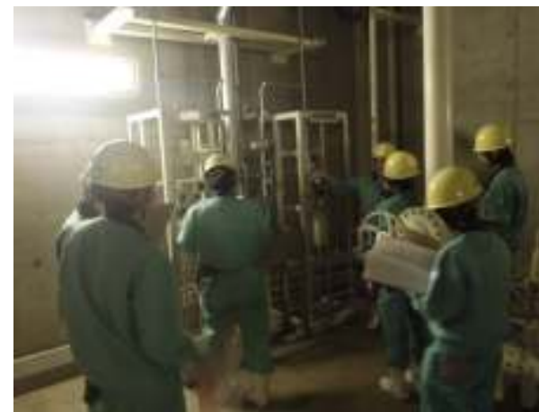
現場サンプリングラックでの試料採取、系統確認
