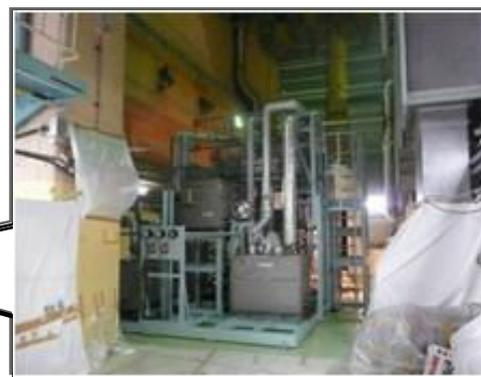
【除湿ロータ式トリチウム除去装置】
