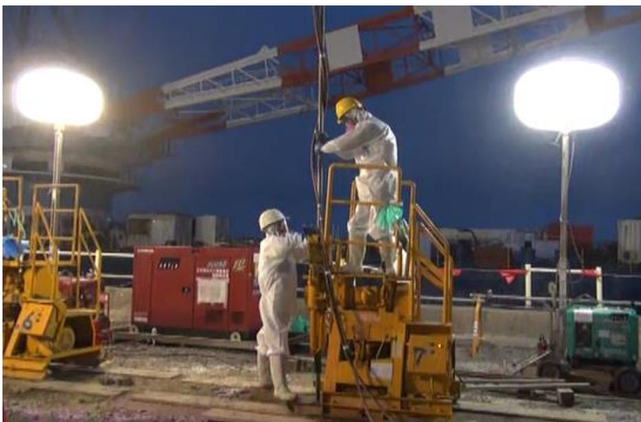
地盤改良（薬液注入）作業の様子
