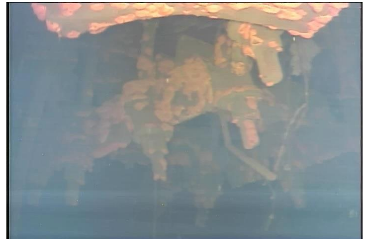
3号機のCRDハウジング下部 出典: 東京電力ホールディングス
