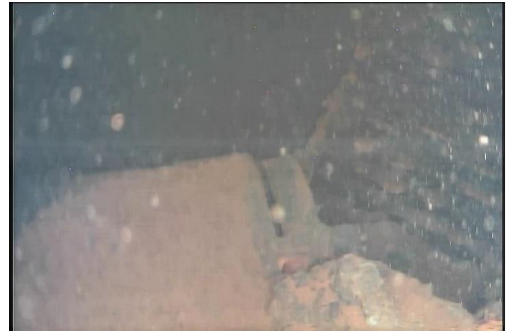
3号機のペDESTAL内 出典: 東京電力ホールディングス
