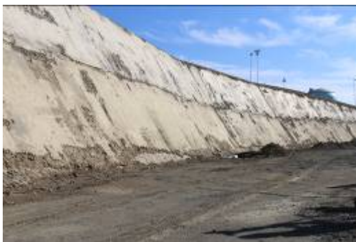
安全性向上対策(防潮堤工事状況)
