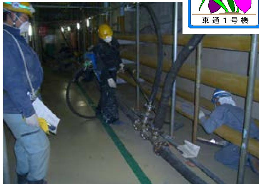
系統構成配管・機器内外面の保管管理の徹底、清浄度の維持
