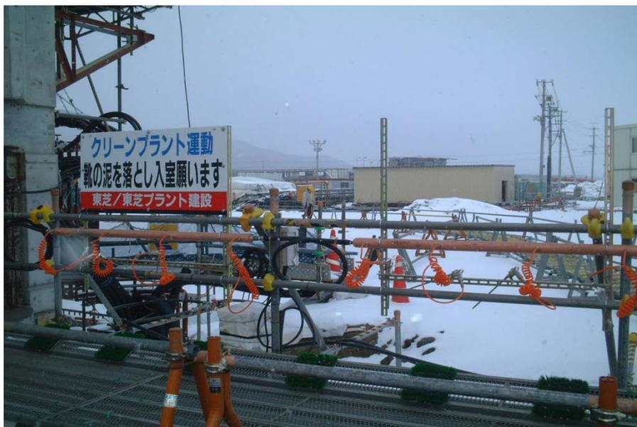
出入口へのエアガン、ジェットスプレー設置による塵埃持込抑制
